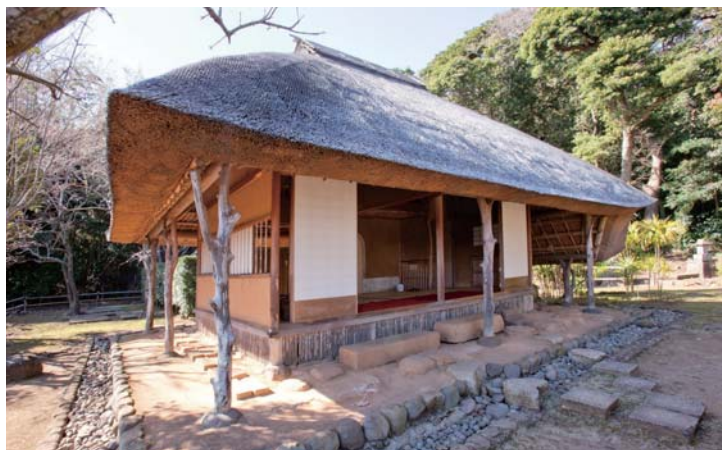
松浦史料博物館の敷地内にある茶室・閑雲亭。農村庶民の質素な住居様式を取り入れた珍しい草庵茶室。
