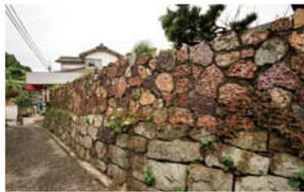
馬車道のトンバイ塀。馬車道には荷馬車の滑り止めであった突起物も残る
